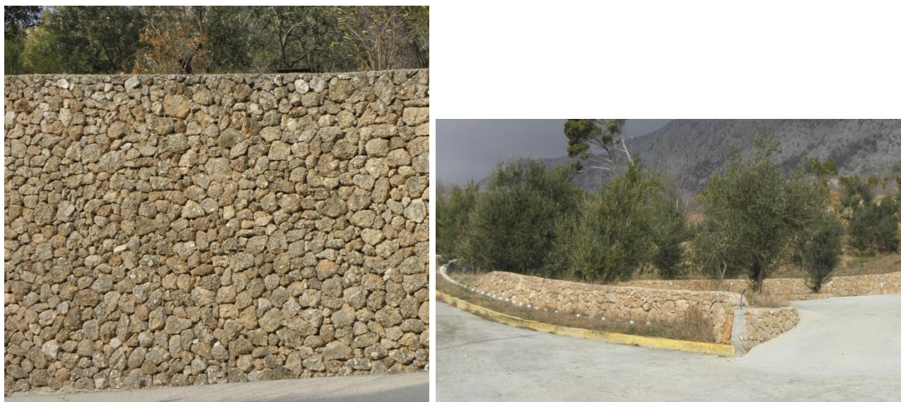
Slika 5. Primjeri potpornog zida obloženog deluvijalnim brečama
